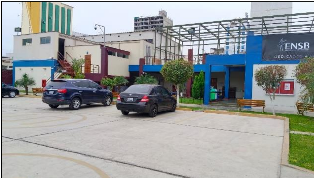
Infraestructura Interna - ENSB
